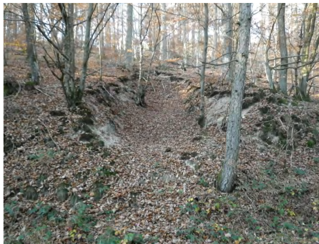
Abb. 8.1 eingebrochener Stollen bei Sierscheid („Alter“ oberer Stollen)
