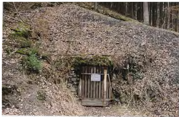
7.4.5 Abb. 14 Limbachstollen Februar 2000
